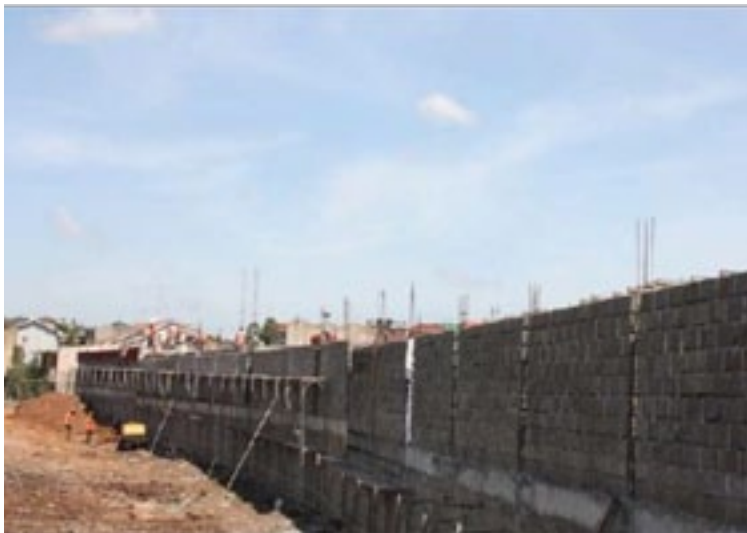
Figura 4: Construcción del muro y de casas en los alrededores de la Tierra de Ferrocarriles Kenia en Kibra.
