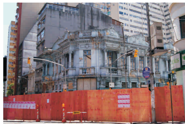
Prédio localizado na Rua Riachuelo tombado pelo patrimônio público e abandonado pelo proprietário aguardando a valorização da terra após a demolição do prédio. Foto: Lucimar F. Siqueira
